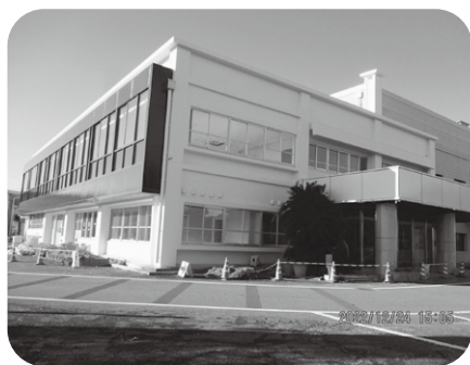
改修中の武蔵中央公民館
