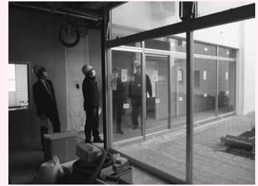
武蔵中央公民館エレベーター 設置場所を確認する
