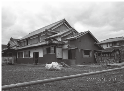
改修中の 国東町内の古民家
